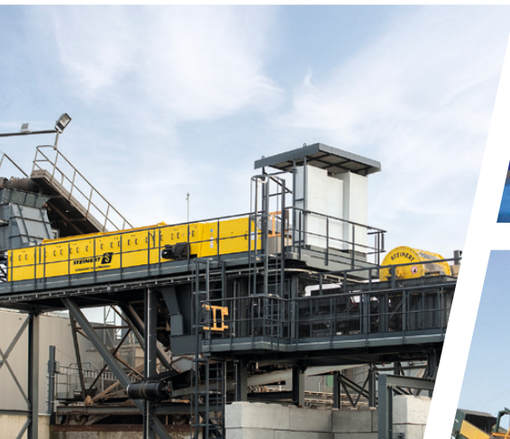
Instalação do STEINERT SteelMaster em andamento em uma planta de reciclagem de veículos em fim de vida na Bélgica
